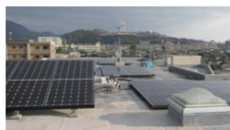
屋上のパネル124枚の設置風景
