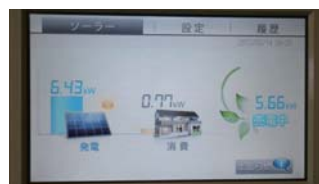
室内モニターで発電と消費・売電が随時確認できます
